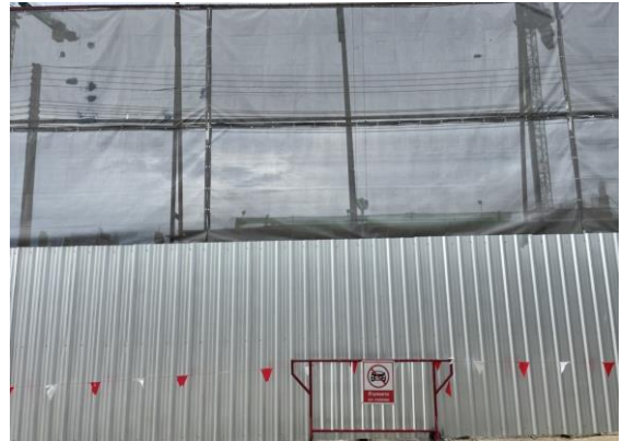
รูปที่ 2 รั้ว Mesh Sheet กันฝุ่น
