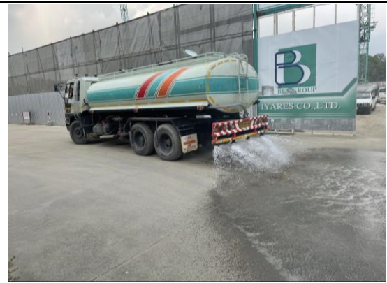
รูปที่ 4 ฉีดพรมน้ำลดฝุ่น
